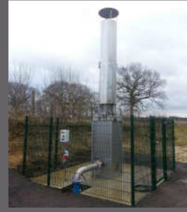
Biogasnotfackeln dienen zur Verbrennung von Biogas bei Wartungsarbeiten oder bei Betriebsstörungen. Dazu stehen manuell oder vollautomatisch betätigte Gasfackeln zur Verfügung. Die Zündung kann dabei sowohl über eine 12 Volt Batterie oder über eine vollautomatische netzabhängige Steuerung erfolgen. Die automatisch betätigte Gasfackel führt sämtliche Zündungs-, Überwachungs- und Sicherheitsfunktionen komplett selbstständig aus.
