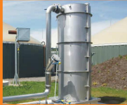
Unser Aktivkohlefilter ist so konzipiert, dass er selbst Schwefelspitzen auffangen kann. Dadurch wird gewährleistet, dass zu keinem Zeitpunkt ungereinigtes Biogas den Filter verlässt. Zudem garantiert das patentierte 3-Kammer-System eine maximale Auslastung der Aktivkohle und fördert dadurch die Wirtschaftlichkeit Ihrer Anlage.
