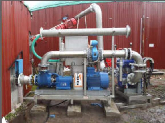
Der BG Gorator® bewirkt eine Aufbereitung der Substrate, so dass die Mikroorganismen die Nährstoffe wesentlich leichter aufnehmen können. Die Methanproduktion wird beschleunigt und die Stabilität des Gesamtprozesses wird nachhaltig verbessert.
