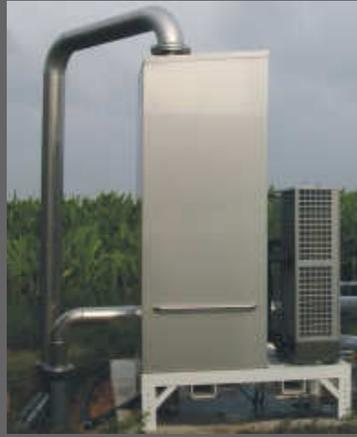
Unser innovatives Kühlungssystem garantiert einen betriebssicheren und effizienten Einsatz von Biogas in Mikrogasnetzen. Der Doppelrohrbündeltauscher (DRBT) ermöglicht es durch sein Gegenstromverfahren, das Biogas äußerst energiesparend und ökonomisch aufzubereiten.
